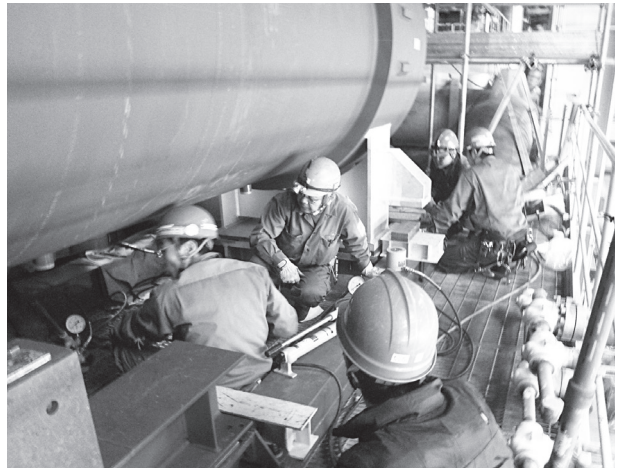
▲発電所での熱交換器（重量80トン）の入れ替え工事。井さんたちはチームとして細心の注意を払いつつ、作業をする。
