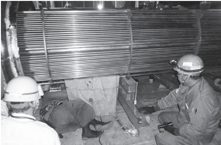
▲熱交換器のチューブバンドル入替工事。チューブバンドルとは熱交換を行う細い管を束ねたもの。井さんは「自分たちが組み立てた機械が問題なく稼働したときが最高の喜び」と語る。
