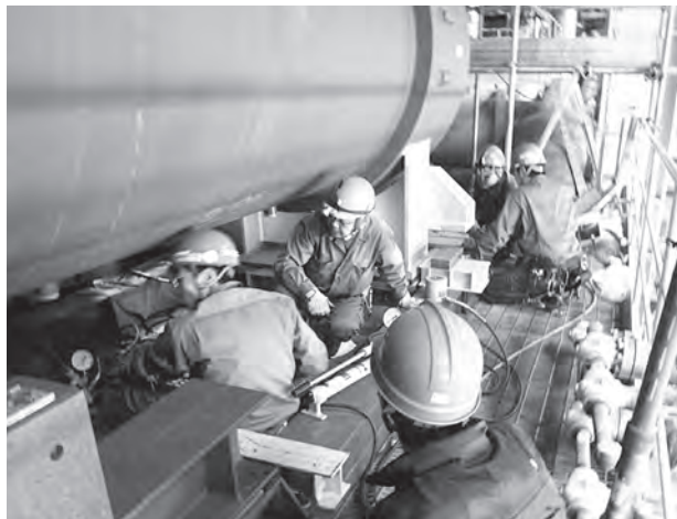
▲発電所での熱交換器（重量80トン）の入れ替え工事。井さんたちはチームとして細心の注意を払いつつ、作業をする。
