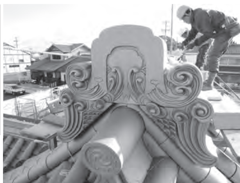
▲寺社の瓦葺き屋根は、場所によって勾配も違い、ねじれもある。しっかり瓦を葺くためにはさまざまな工夫が必要であり、腕の見せ所でもある。現寸図通りに瓦を葺くことができれば一人前である。
